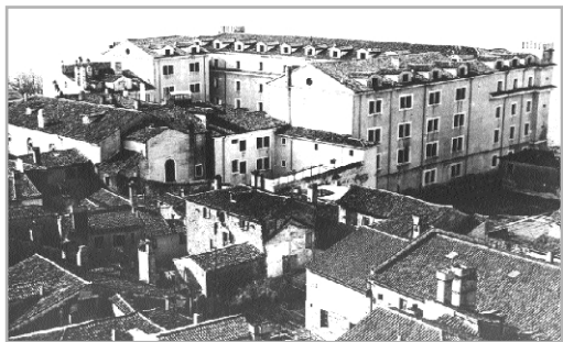
Slika 7.1: Dva-kratni sporni poseg: izgraditev avstrijske jetnišnice in rušenje kompleksa na Belvederu
