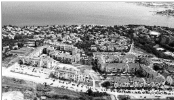
Slika 3.7: Zgrajeni del Žusterne III
