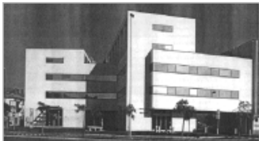
Slika 7.3: Kako se novo vključuje v kontekst na robu starega mestnega jedra? Izziv: poslovno-stanovanjski objekt Mandrač, arh. Vojteh Ravnikar
